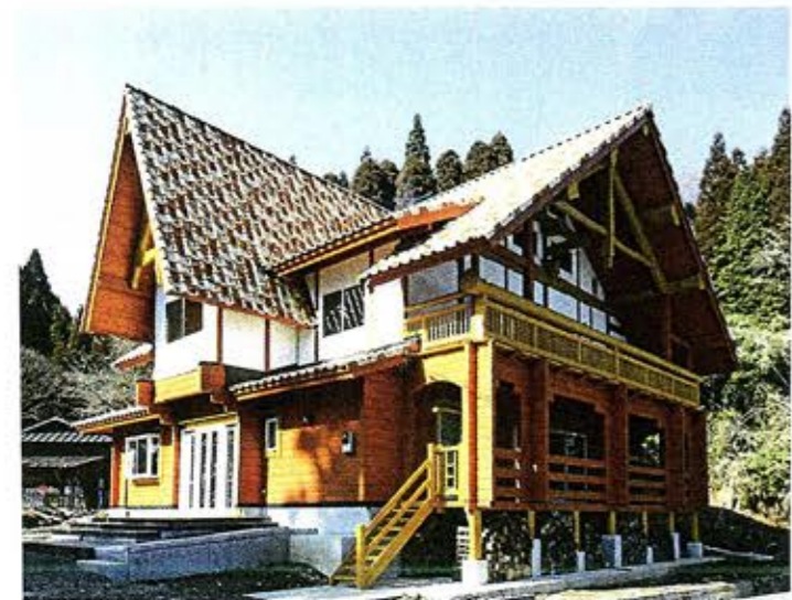
外壁面 (木あじ、テリオスウッド)
